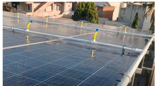
Figuur 5 Illustratie van een reinigingssysteem op verschillende zonnepanelen met sproeikoppen.
