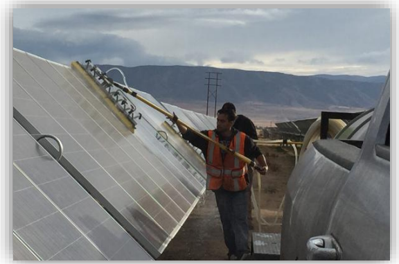
Figuur 10 Schoonmaak proces van PV-zonnepanelen
